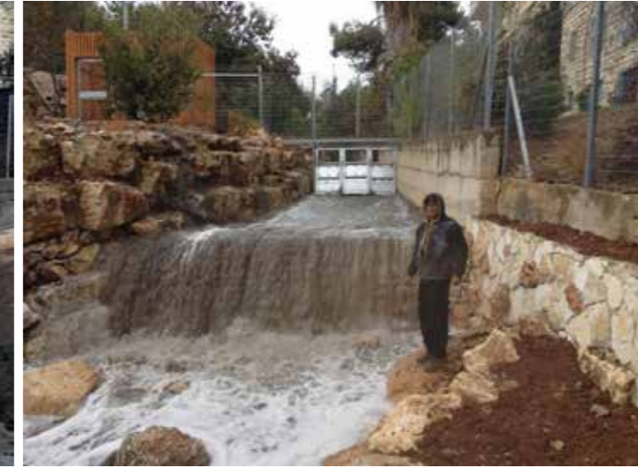
▲ מימין: כניסה צפונית לנחל רקפות. שערי המים נפתחים בזמן שיטפון. משמאל: אותה הכניסה במראה יבש
